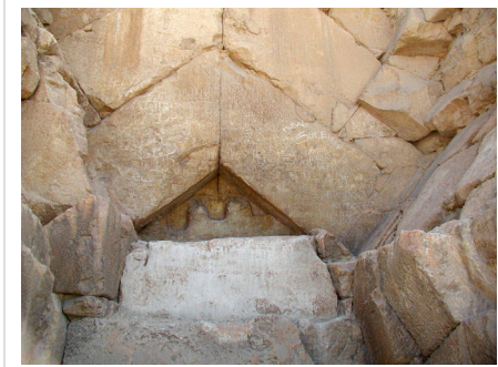
Système de couverture, entrée de la pyramide de Khéops
