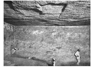
Intérieur de la chambre souterraine
